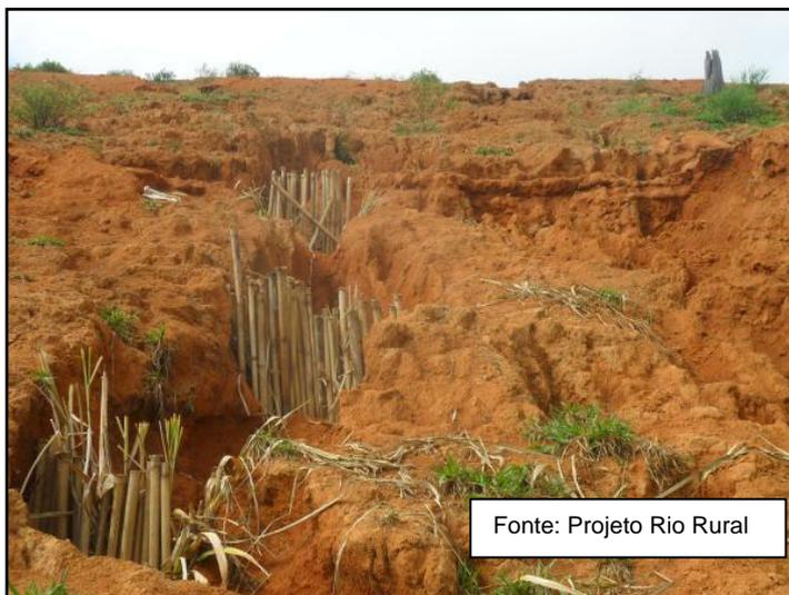
Próximo à beira da parede da voçoroca, protegida com paliçadas, recomenda-se construir uma barreira para evitar que a água atinja a paliçada. Essa barreira pode ser um terraço, acoplado a um canal escoadouro, ambos vegetados, ou uma fileira de sacos de terra, empilhados longitudinalmente à beira da voçoroca. É importante vegetar os sacos de terra, principalmente os de rafia, para não serem degradados rapidamente pelo sol.
