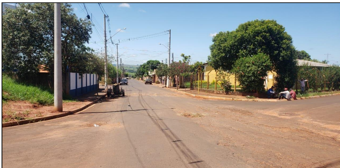
Figura 5 – Poço de visita existente – Local da interligação.
