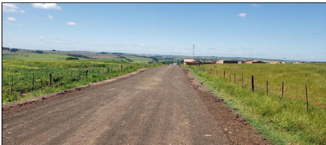
Figura 1 – Local do início da captação de águas pluviais.
